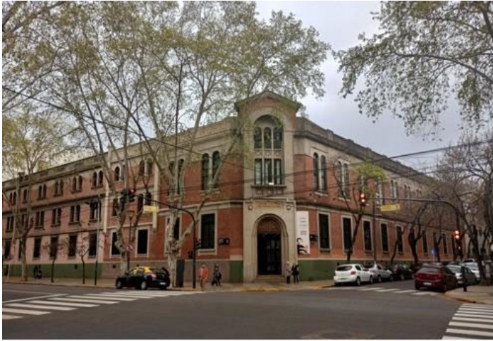
Av. Hipólito Yrigoyen 3900 esq. Yapeyú – Cautelar grado 3 Colegio San Francisco de Sales
